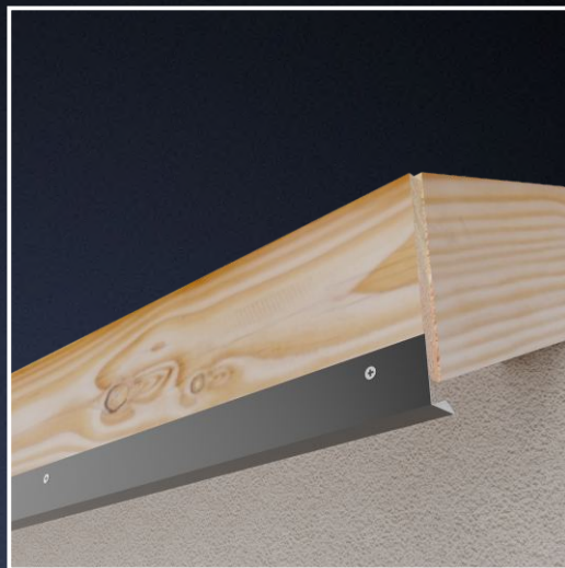
Montaż listwy startowej
