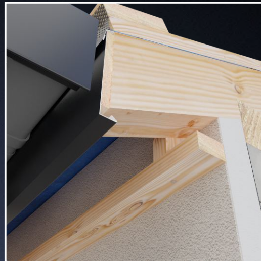
Montaż stelaża do mocowania podbitki.
