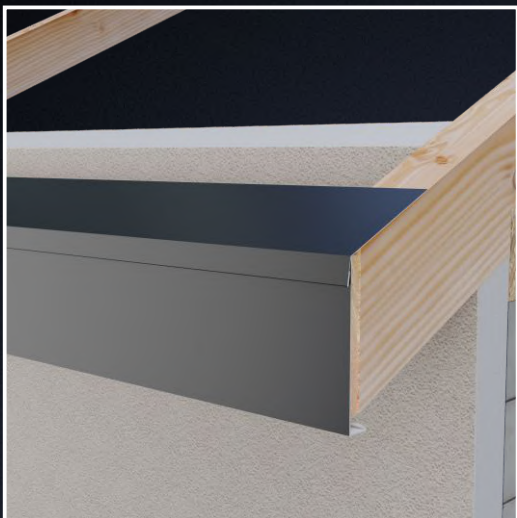
Montaż pasa podrynnego (skroplinowego).
