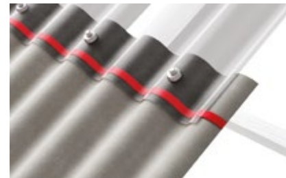
29 pav. Skaidrūs lakštai „Eurolux“, sumontuoti aukščiau banguotųjų lakštų „EuroFala“, skersinė užlaida.
